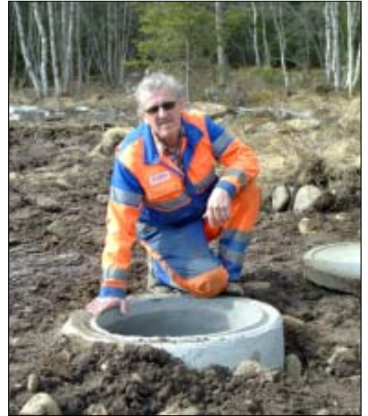
Jan Lien holder på med planering utenfor vannverket på Innset.
