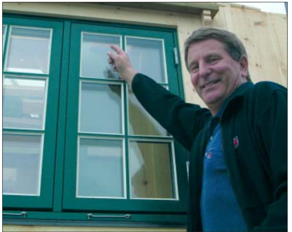
Ivar Langklopp ved LH Bygg AS sier at karmventiler i vinduene holder godt til ventilasjon av vanlige oppholdsrom.
