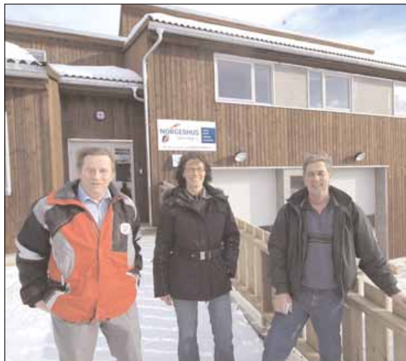
Ordfører Bjørn Rogstad, sekretær i byggekomiteen Lill H. Bøe og leder i byggekomiteen Jon Olav Viggen inspiserer den nye ambulansebasen.
